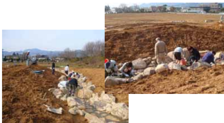
水路のコンクリート塗り作業
