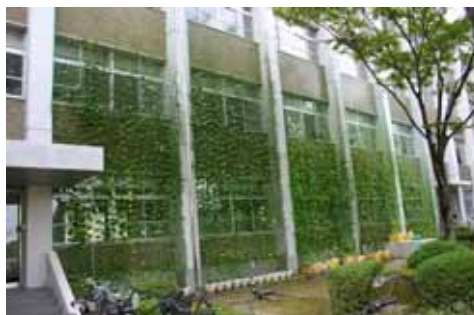
ヒートアイランド緩和等を目的とした農学部本館の壁面緑化施工
