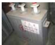
安定器の保管状況
