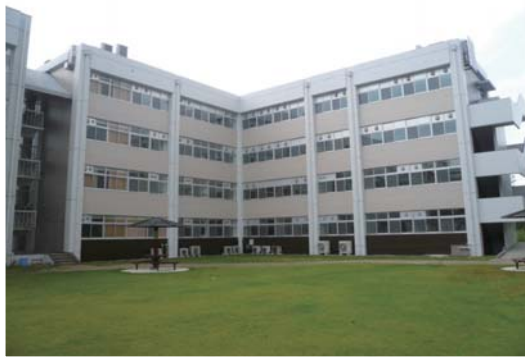
図4-2 国際総合科学部本館改修工事完成
