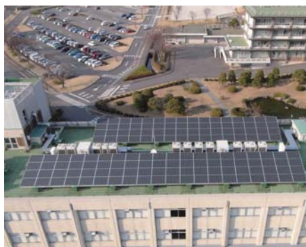
図2-2 太陽光発電設置
