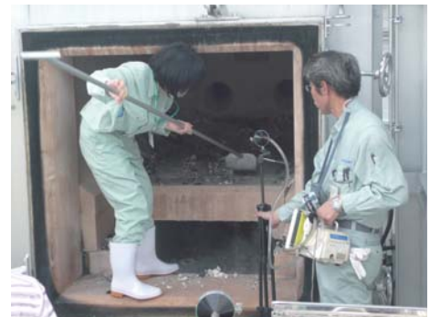
図5-2 ダイオキシン濃度の測定
