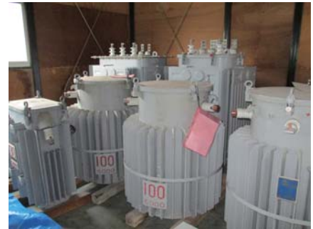
図5-1 PCBの保管状況
