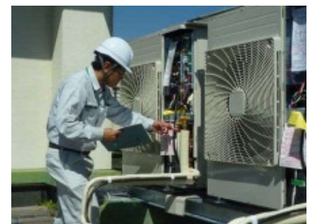
図6-2 工事現場の管理
