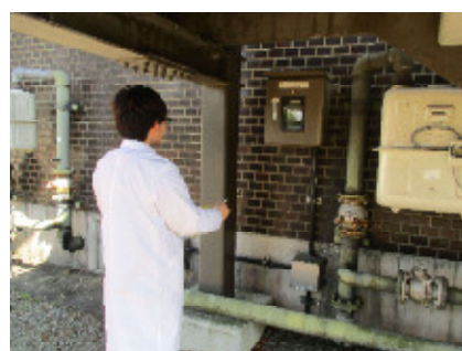
図6-13 実験排水pHセンサー点検
