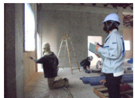
図6-2 工事監理（断熱材の確認）
