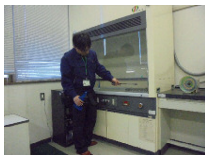
図6-6 局所排気装置の制御風速確認
