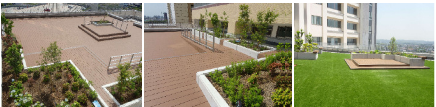
図5-31 新病棟（A棟）7、8階屋上庭園
