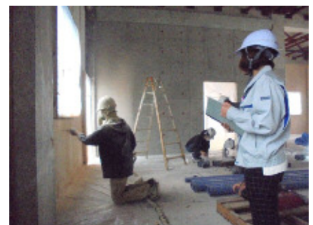
図6-2 工事監理（断熱材の確認）
