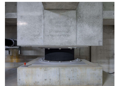
図4-24 A棟 基礎免震構造
