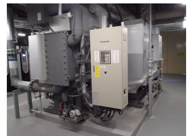
図4-25-1 A棟 熱源（冷凍機）
