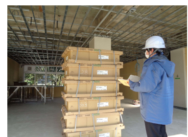
図5-2 工事監理（機材検査）
