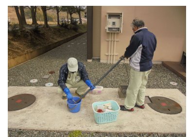
図5-11 実験排水pHセンサー点検
