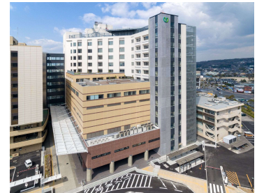
図4-23 A棟 新築状況
