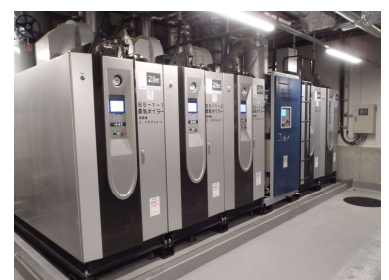
図4-25-2 A棟 熱源（ボイラー）
