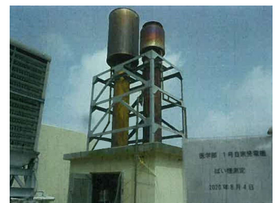
図5-2 自家発電装置の煙突
