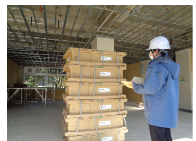
図5-3 工事監理（機材検査）
