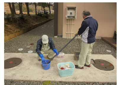
図5-10 実験排水pHセンサー点検
