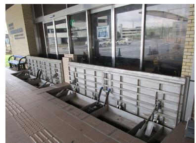
図2-5 外来入口の止水板の起動確認
