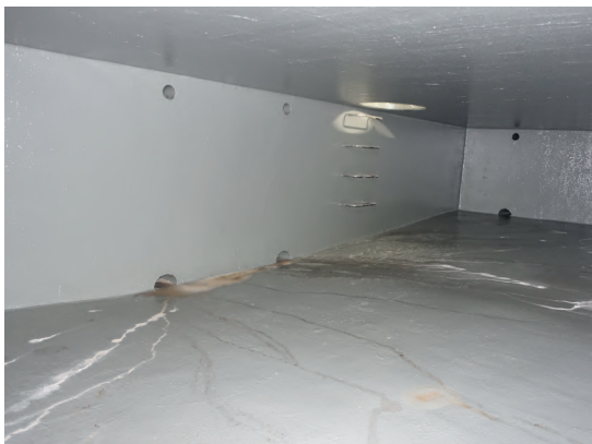
図 2-4 病院施設の防災用トイレとしての地下汚水槽の設置状況
