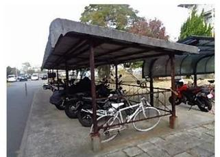
④ 屋根付き駐輪場：鋼材の錆・腐食や基礎部の破損等、一部に老朽化の著しいものがある
