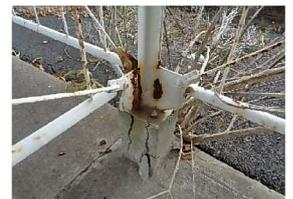
⑥屋根付き駐輪場：鋼材の錆・腐食や基礎部の破損等、一部に老朽化の著しいものがある
