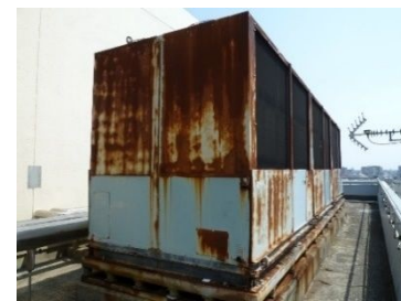
老朽化した空調設備
