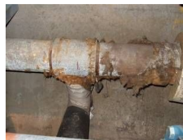
老朽化した屋外給水管
