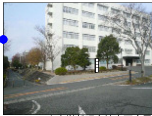
人文学部研究棟南面全景
