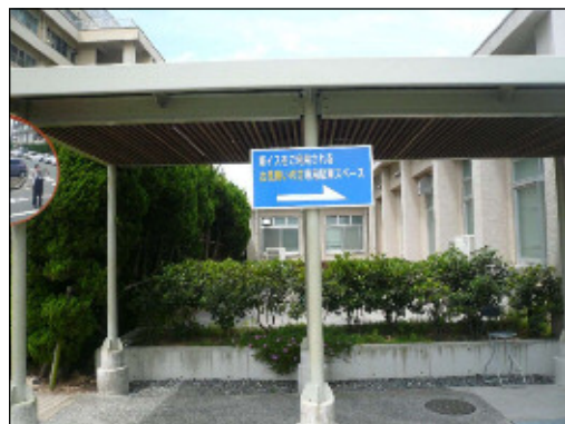
渡り廊下支柱に固定された誘導サイン
