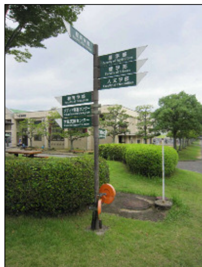
誘導サインに取り付けられたカーブミラーと 破損したサインの支柱のみ(右側)
