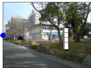
機械実習棟西側廻り全景
