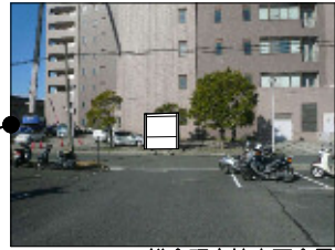
総合研究棟東面全景
