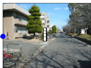
大学院技術経営研究科棟 東面全景
