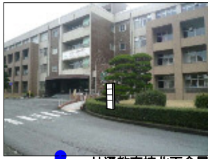
共通教育棟北面全景
