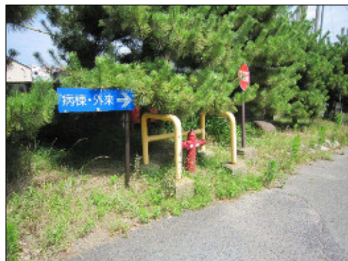
規制サイン（消火栓）
