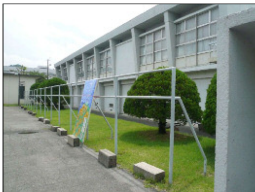
臨時掲示用の鉄骨支柱
