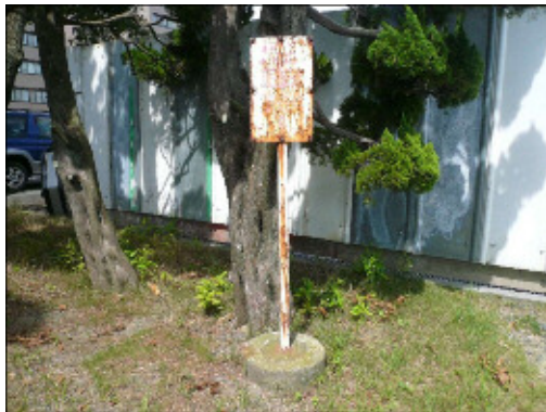
老朽して見えない規制サイン
