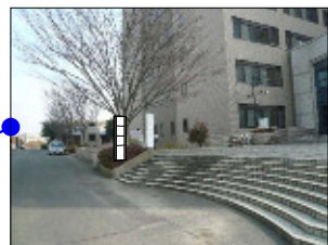
電気電子棟玄関廻り全景
