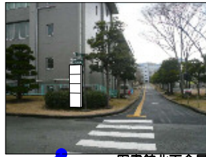
図書館北面全景
