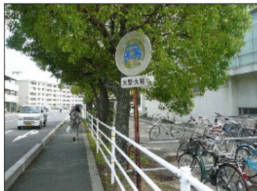
汚れている規制サイン
