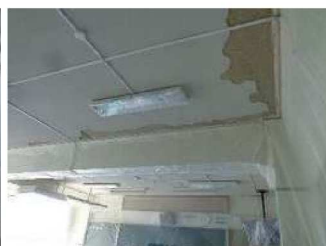
モルタル浮き部の 緊急修繕状況(R4.4)
