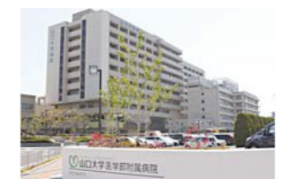
【病院正門からの外観】
