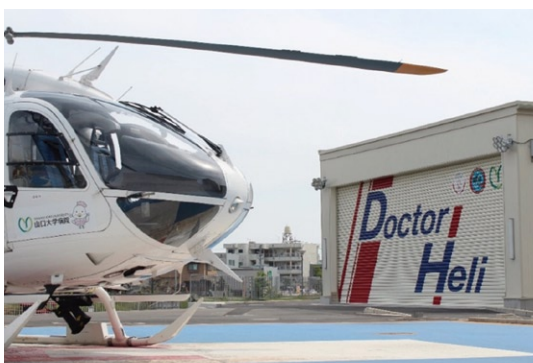
完成した格納庫
