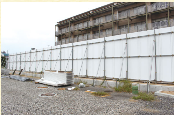
仮囲いの様子(保健学科研究棟前)
