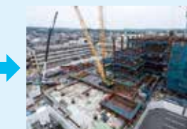
平成29年8月、5階床部分まで骨組みが上がってきている他、外来診療棟側の側面ではコンクリートの外壁ができています。
