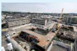
平成28年6月、地下工事が着々と進み、作業・資材仮置用スペース確保のため、大きな鉄棧橋のような仮設構台を設置しました。
