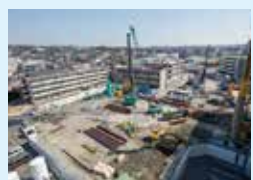
平成28年6月、地下工事が着々と進み、作業・資材仮置用スペース確保のため、大きな鉄棧橋のような仮設構台を設置しました。
