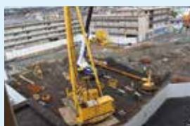
平成27年10月、地下工事を開始しました。
