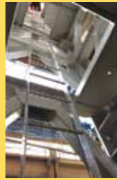
地面と垂直に伸びる タワー
