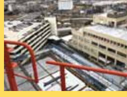
立体駐車場と 外来診療棟を見下ろす
