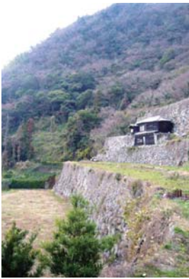
島の原野の中に忽然と現れる平さんの棚田(石垣6段、高さ計38メートル)。「天空の棚田」とか、「城壁」などとも呼ばれて全国から沢山の方々が見に来られます。港からは徒歩で一時間と少し掛かります。
