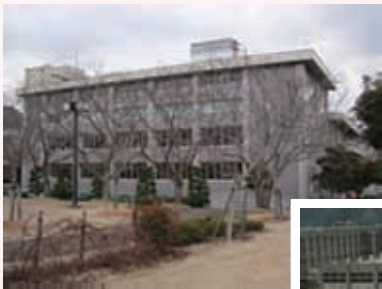
総合図書館現況（北西から）
