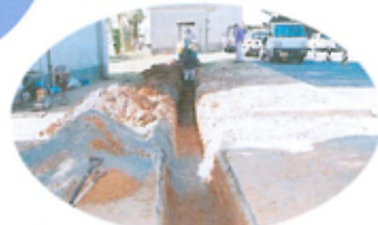
工学部職員宿舎での立会調査
