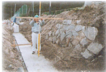
光構内での立会調査
