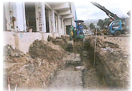
吉田構内共通教育棟での立会調査風景
