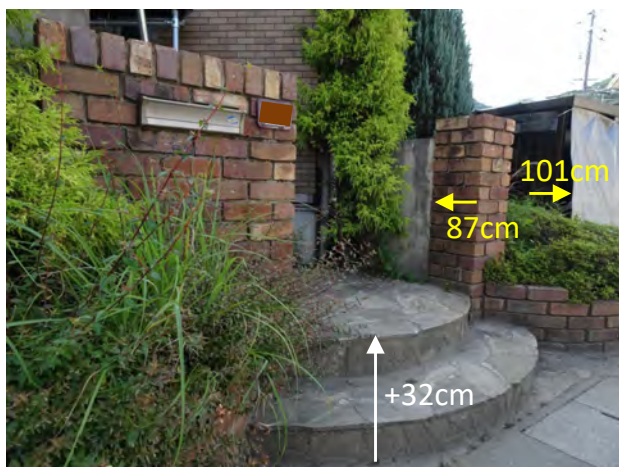
写真 4.5 床上浸水した住宅の浸水痕跡
