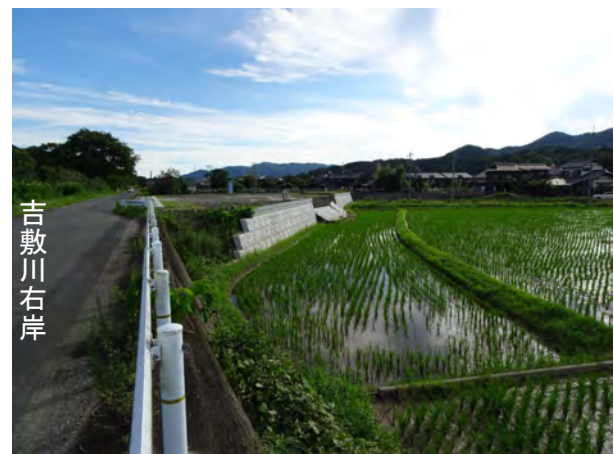
写真 2.19 造成中の住宅地における擁壁の崩落 被害（3 日撮影）
