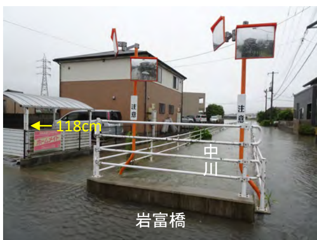
写真 2.6 岩富橋付近における浸水の状況（1 日 7 時 47 分撮影、岩富地区）
