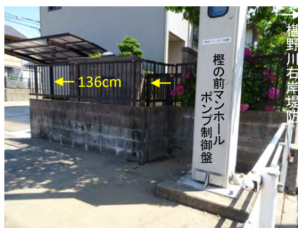
写真4.3 カーポートの浸水痕跡とポンプ制御盤
