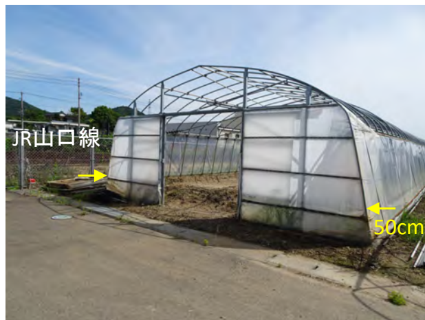
写真 4.7 農業ハウスにおける浸水痕跡
