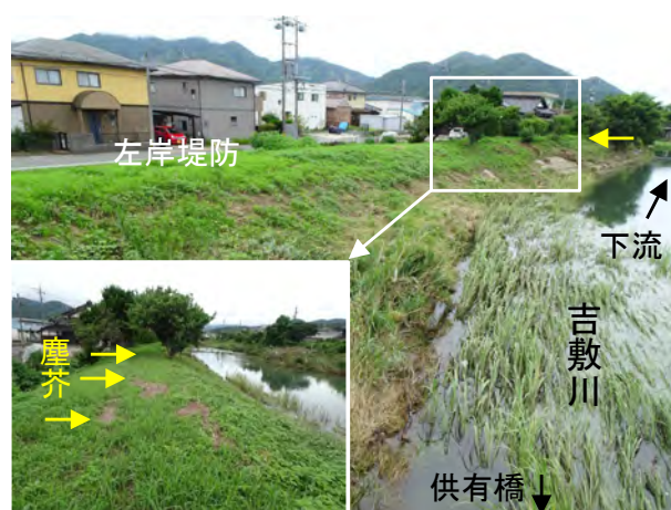
写真 2.11 吉敷川に架かる供有橋の下流の左岸堤防における塵芥の状況（3 日撮影）
