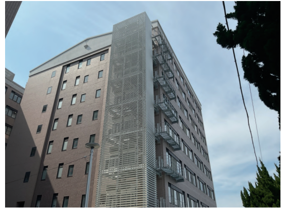
図 5-16 機械・社建棟外観（室外機置場）
