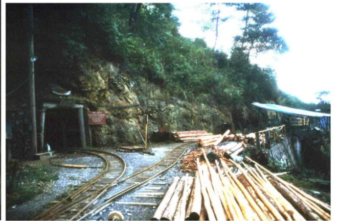
喜和田鉱山の通洞坑口
