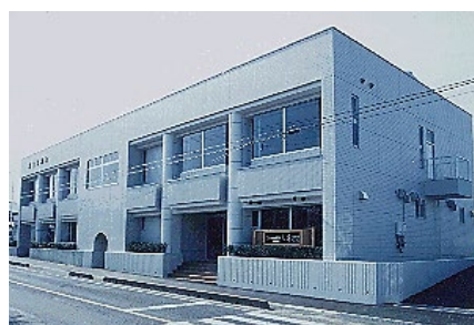
常盤工業会館（工学部正門向かい）
